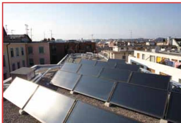
**Les besoins en eau chaude sanitaire restants (56%) sont assurés par 40 m<sup>2</sup> de capteurs solaires.**
