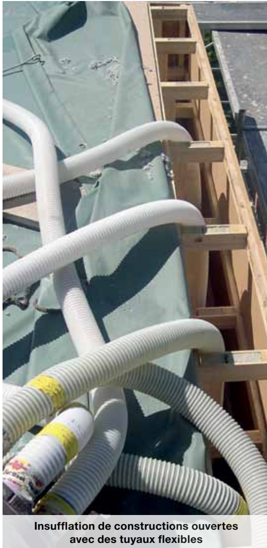
Remplissage d'éléments à la lance d'insufflation
